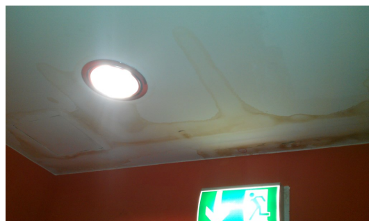
Decke im Flur der BPOLI F, Foto Ch. Ackermann
